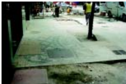
Figura 3 – Descrição da obra
