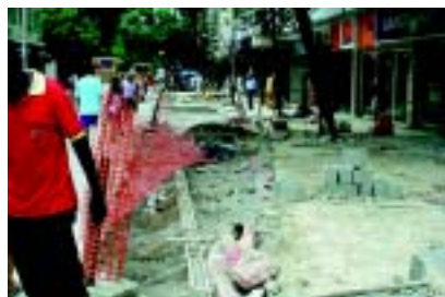
Figura 4 – Descrição da obra
