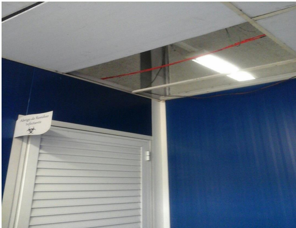
Placa do teto ausente no compartimento do lixo-CF Herbert de Souza
