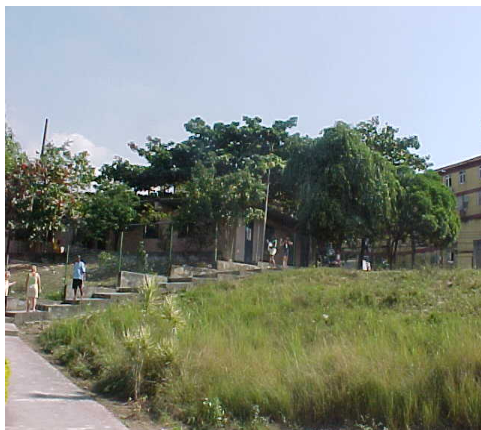
Foto 2 – Acesso à Unidade por rampa
