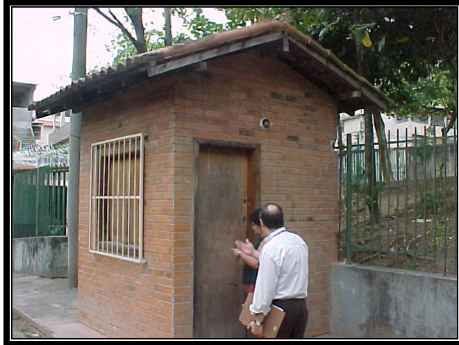
Figura 9 - Almoxarifado de material de consumo.
