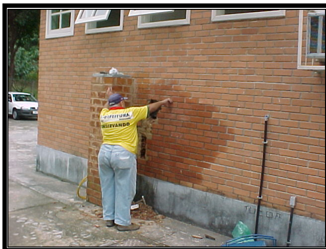
Figura 11 - Empresa de manutenção predial em ação.
