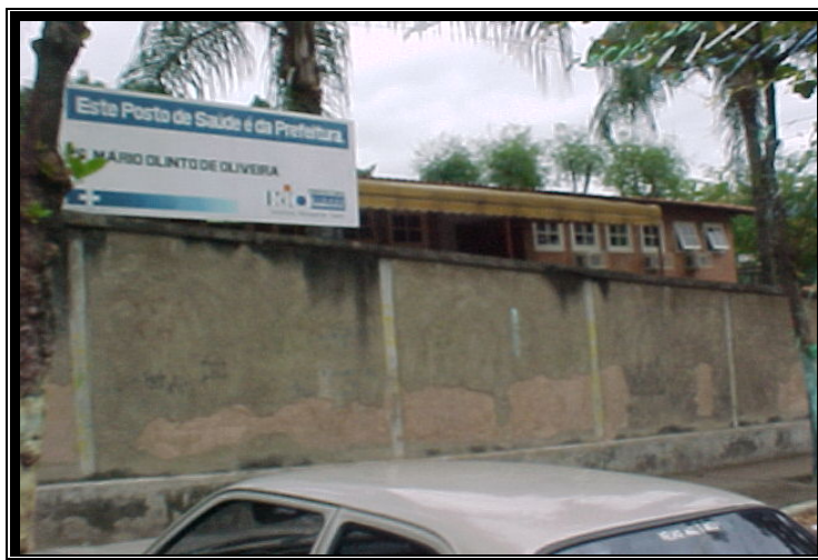
Figura 1 - Fachada da Unidade.
