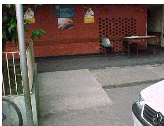
Figura 5 – Rampa de Acesso aos Deficientes.
