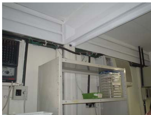
Figura 8 Fiação exposta
