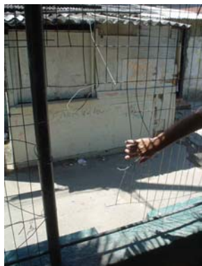
Figura 3 Grade com buracos
